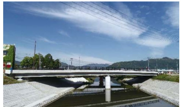
架け替えが完成した国道9号若宮橋
