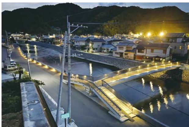
特殊堤や高欄にLED照明を設置
